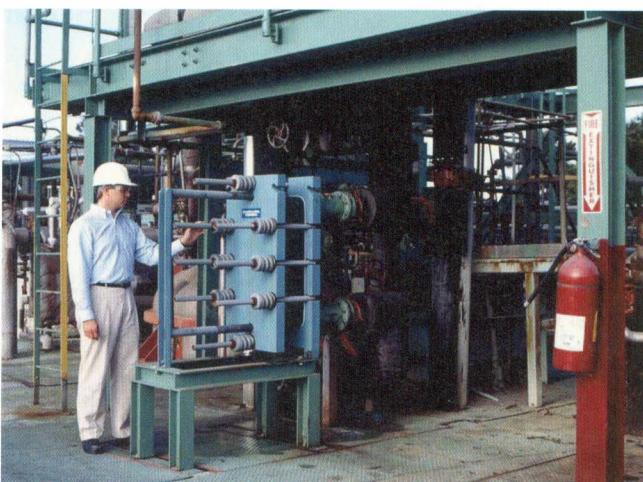
米国の工場で塩酸と塩素系炭化水素の混合物の冷却に使用されているDIABON® F100アルファ・ラバルプレート式熱交換器
