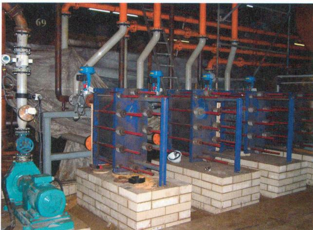
ドイツの製鉄所で炭素鋼の酸洗液の冷却に使用されているDIABON® NS1アルファ・ラバルプレート式熱交換器
