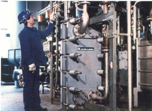
ドイツの工場で塩酸の冷却に使用されているDIABON® F100アルファ・ラバルプレート式熱交換器
