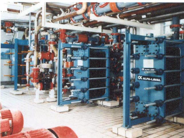
フィンランドの亜鉛精錬所の水銀回収工程で弱硫酸の冷却に使用されているDIABON® F100アルファ・ラバルプレート式熱交換器
